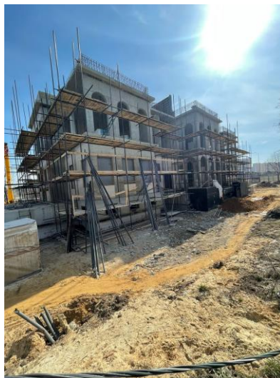
Рис. 5. – Ход строительства строительства здания «Приходской дом»
