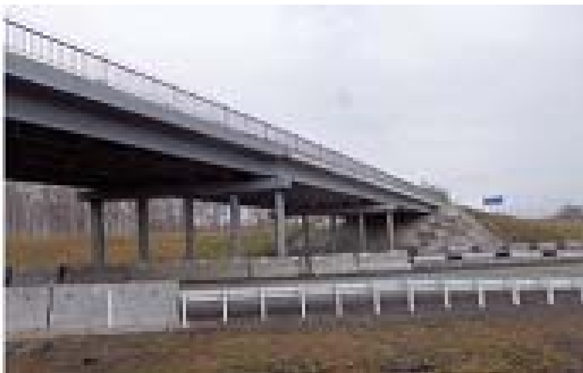
Рис. 2 – Общий вид обследованного путепровода
