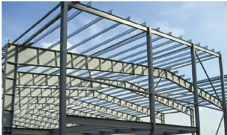
Рис. 1. – Z-образный стальной тонкостенный холодногнутый профиль в качестве прогонов
