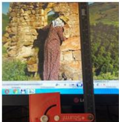
Рис. 2 – Визуальное и инструментальное обследование конструкций башенных строений
