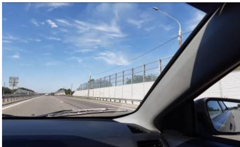
Рис. 3. – Шумозащитный экран вдоль Восточного шоссе (вид из автомобиля)
