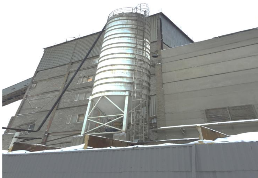
Рис. 1. – Этажерочный цех по производству товарного бетона
