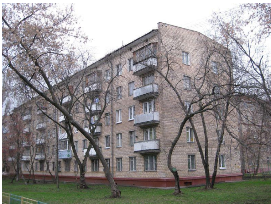
Рис. 1. – Фотография 5-этажного жилого дома по типовому проекту №1-511-3/М4Б [14]
