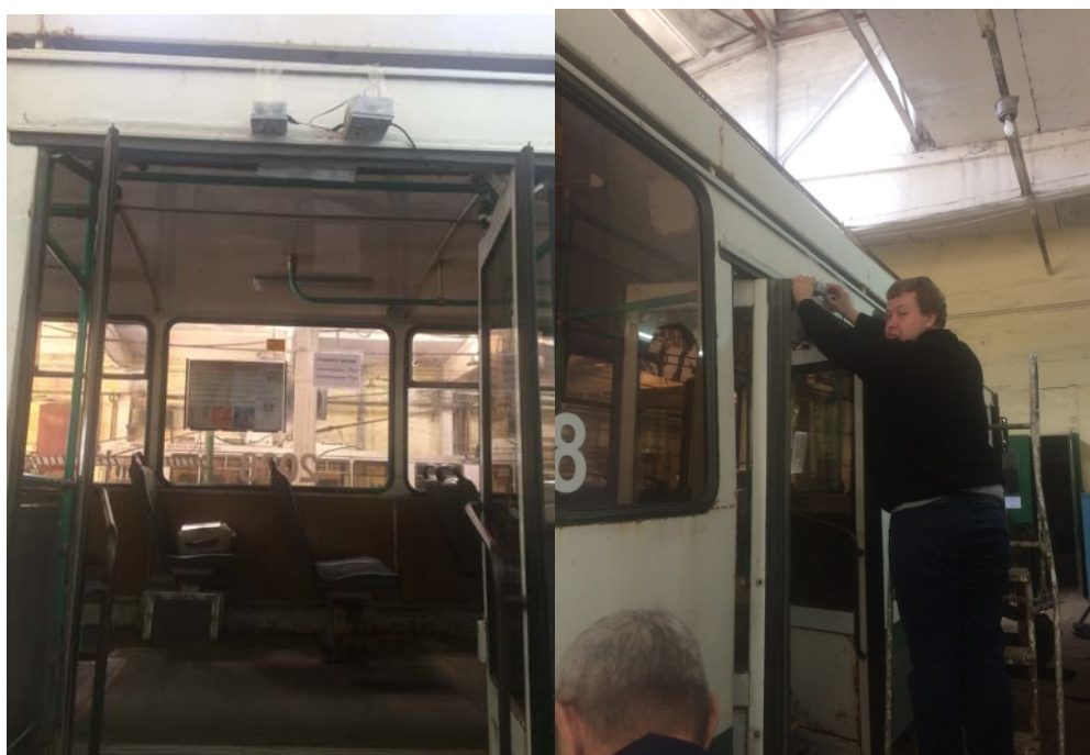
Рис. 2. – Установка устройства над дверным проемом троллейбуса
