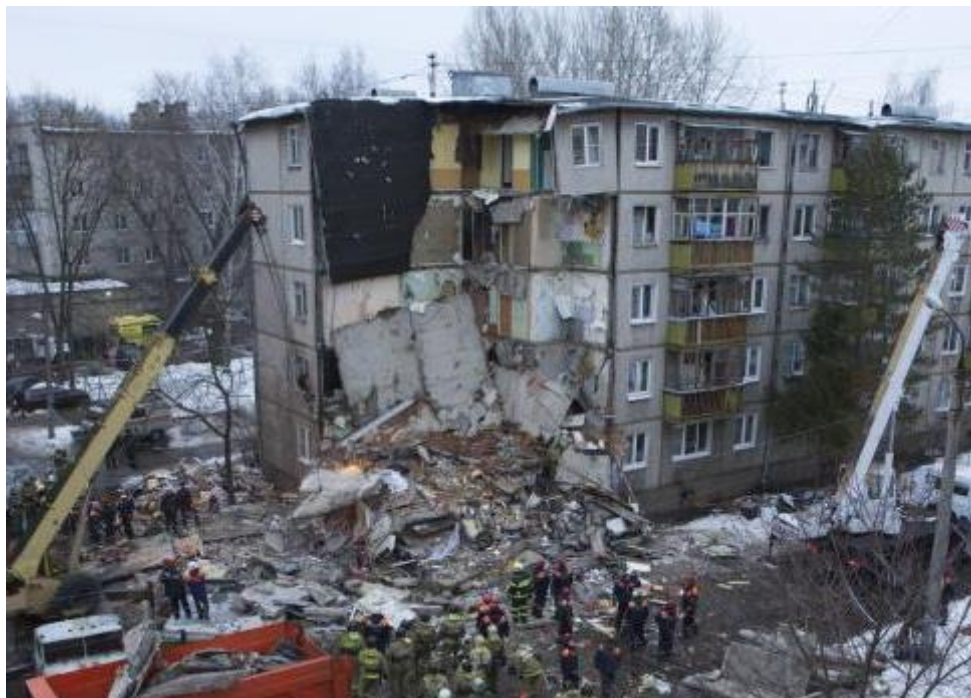
Рис. 3. – Объект №2 [12] классификации, разрушение части угловой секции здания
