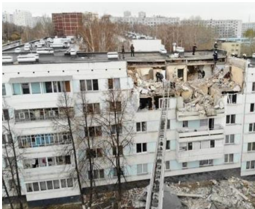
Рис. 3. – Объект №2 [12] классификации, разрушение части угловой секции здания
