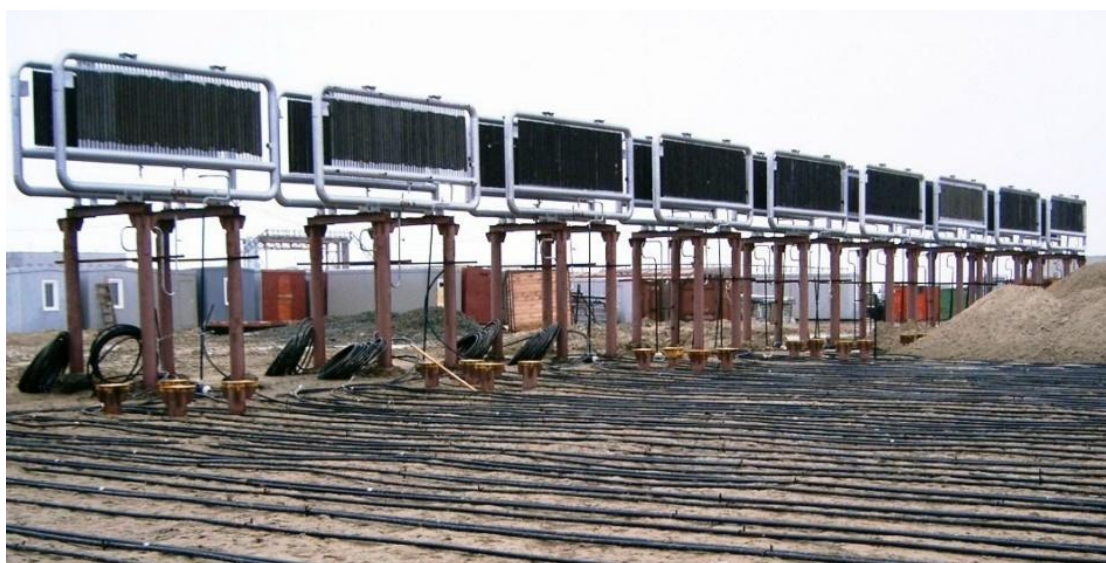
Рис. 1. Горизонтальные естественно действующие трубчатые системы.
