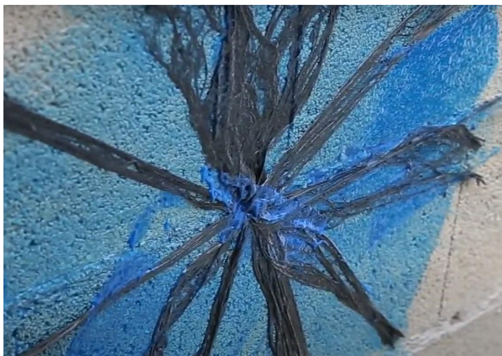
Рис. 2 – Установленный анкерный жгут (Авторская разработка)
