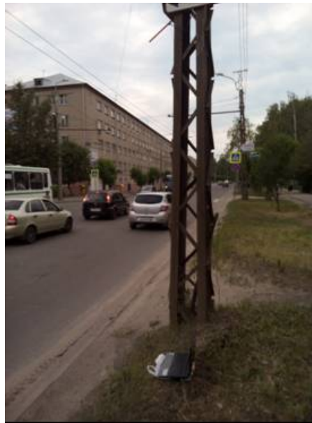
Рис. 2. – Установка микрофона типа “бегущая волна” на улично-дорожной сети
