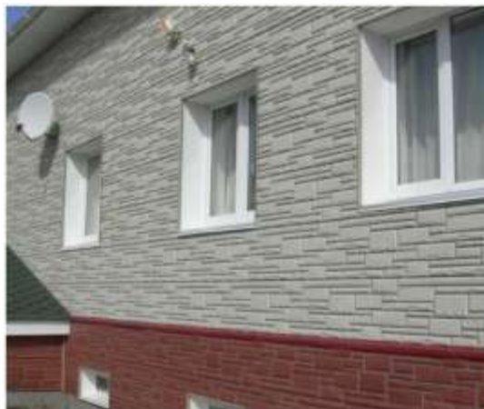
Рис. 21: Пластиковые облицовочные панели на фасаде [24].
