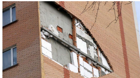
Рис. 3. – Дефекты стен с облицовочным кирпичным слоем: а – разрушение слоя с пониженной паропроницаемостью; б – обрушение кладки
