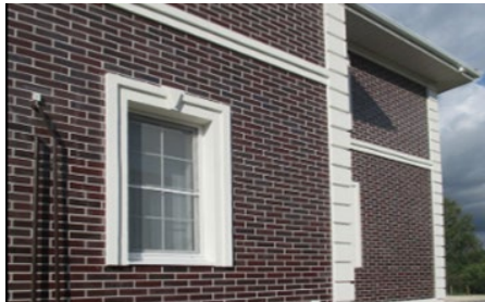
Рис. 4. – Декоративное отделочное покрытие из мраморной крошки на акриловой основе: а - пример оформления фасада: б – фрагмент листа
