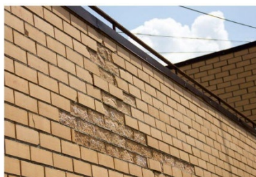
Рис. 3. – Дефекты стен с облицовочным кирпичным слоем: а – разрушение слоя с пониженной паропроницаемостью; б – обрушение кладки
