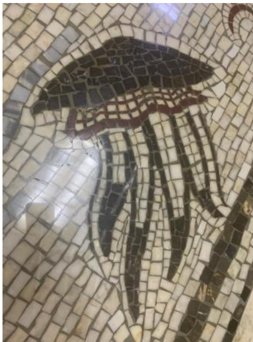
Рис. 3. – Поверхность с дефектами.
