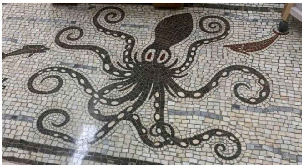
Рис. 4. – Мозаичное покрытие после полировки.
