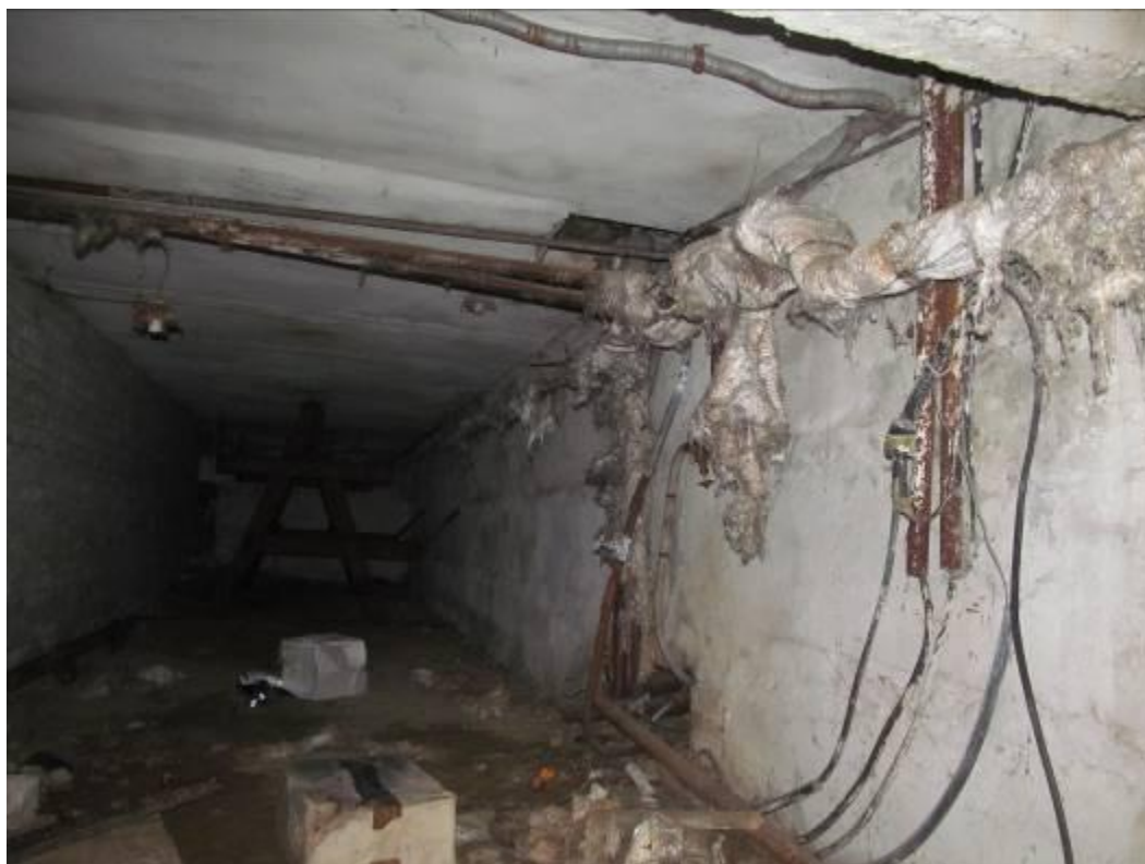
Рис 2. - Вид общей стены в подвале нежилого помещения
